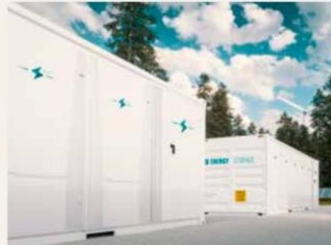
Container de stockage (640-1100 V, 6 MWh dans container 40")
