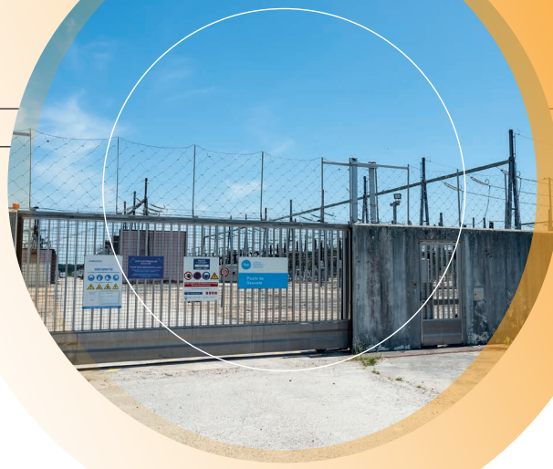
Poste électrique de Saucats (2021)
